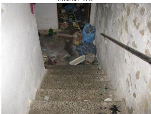
Schodišče do sklepa
